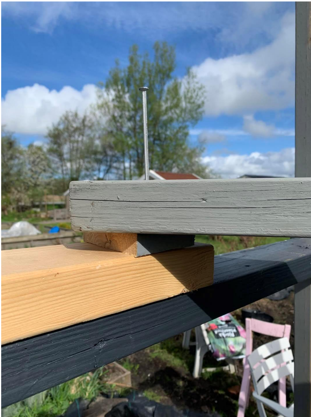
Foto på en inslagen spik med vilken jag fäste en regel, kloss och ytterligare regler i bygget av det nya växthuset
