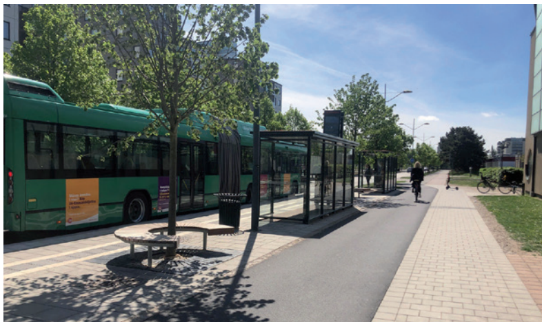
Figur 4. En hållplats på Västra Varvgatan i Malmö har byggts med utgångspunkt i ett utformningsförslag som togs fram av Fastighets- och gatukontoret. Upplägget med två korta väderskydd möjliggör god kontakt mellan hållplatsen och omgivningen. Träden är tillsammans med väderskydden viktiga för att skapa rum med mänsklig skala. De cirkelformade bänkarna under träden skulle behöva kompletteras med ryggstöd och armstöd för att även kunna fungera för personer med funktionsnedsättning. Foto: Emma Paulsson
