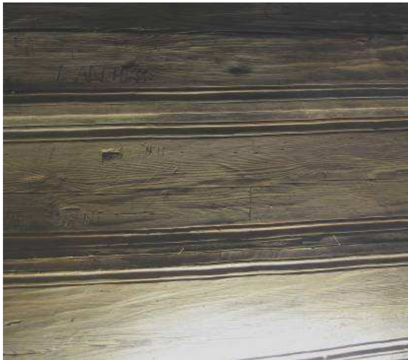
BILD 2. Exemplifierande väggyta i koret med tre särskilda hyvelspår. Överst en skave med tämligen krökt egg (spårbredd 20 mm: spårdjup 0,8 mm), nederst en skave med relativt rak egg (25:0). Timret i mitten är hyvlat med en skave som ligger de båda tidigare nämnda emellan (25:0,3). Som synes (nedersta timret) hyvlade man inte sällan lite på skrå, vilket kan indikera att hantverkaren stod vid sidan av arbetsstycket och inte rakt över.
