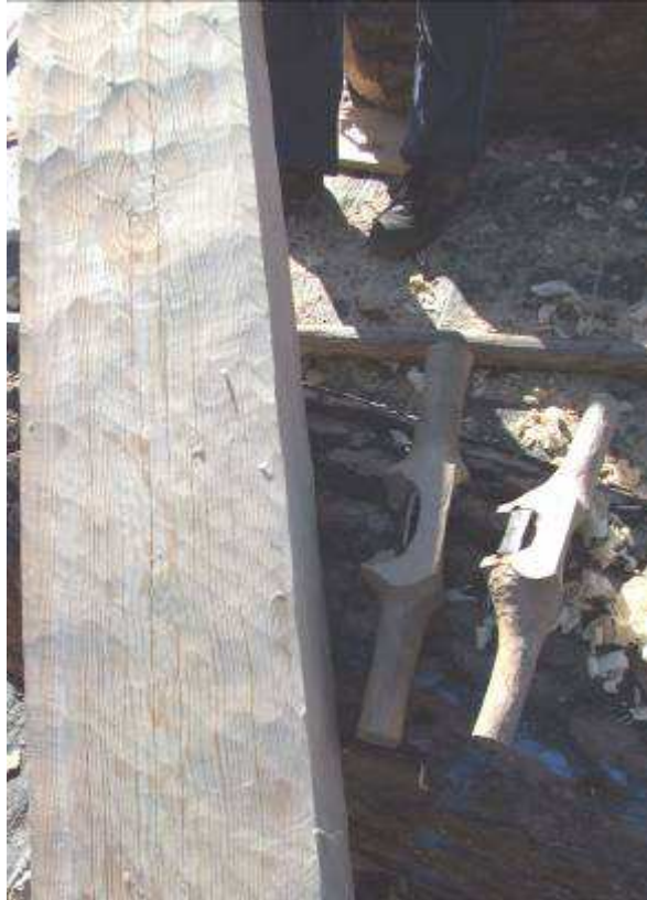
BILD 17. Här har vi gjort ett försök med skråhyvling, i syfte uppnå en måttriktig hyvlad yta. Hyvlar man på fel vis riskerar man att tappa den måttanvisning som finns inbyggd i den huggna ytan. Foto Södra Rådaprojektet.
