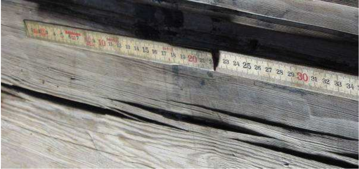
BILD 5. I några fall kunde vi mäta upp hela hyveltag, på bilden ett tag som mätte 30 cm. I regel saknas den del av hyveltaget där man inleder momentet -startmärket (se under 30-31 cm). Lägga märke till den abnorma mörkspäckan. Foto Robert Carlsson.
