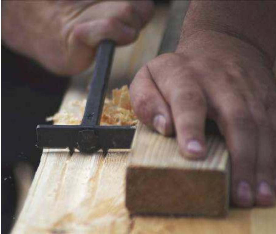
BILD 20. Här dras profilen upp längs kanten på ett väggtimmer, lägg märke till det provisoriska anhållet. Foto P Westerlund, Skaraborgsbild.
