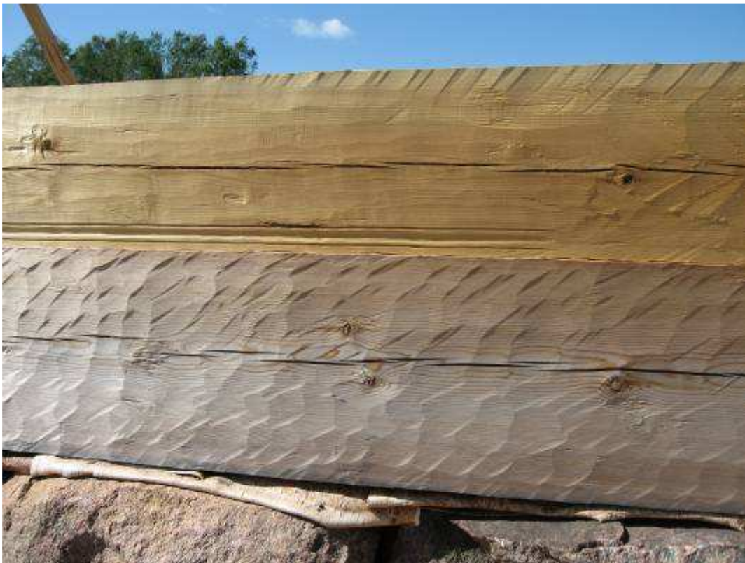
BILD 18. Långhusets södra sida på kyrkorekonstruktionen – behuggning, hyvling och profilering. Foto Robert Carlsson.
