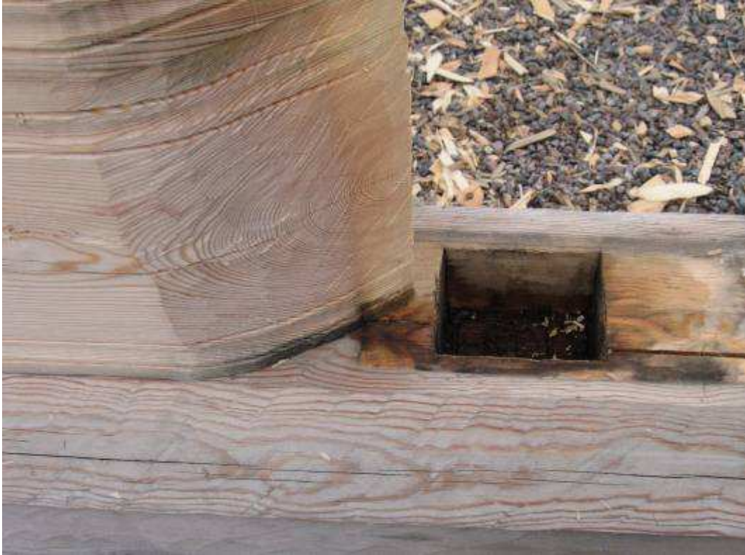
BILD 16. Sydportalens östra post, man ser hur tapphållet varit vattenfyllt efter en säsong i det fria. Av detta kan man dra slutsatsen att sydportalen var konstruktivt undermålig med avseende på exponering för väder och vind. Lösningen förutsätter i princip en skyddande konstruktion, ett vapenhus, för att ge konstruktionen rimlig livslängd. Foto Robert Carlsson.
