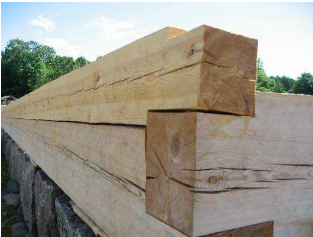
BILD 3. Långtimret LN 2 var skevt innan det lades in, men skevade iväg ytterligare på sin plats i väggen. Foto Robert Carlsson.
