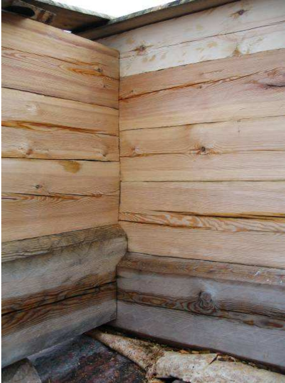
BILD 17. Hörnet LÖ-LS. Lägga märke till övergång från syllar till vägg. Stighöjderna är under kontroll. Lägga märke till att stommen snabbt blir påverkad av väder och vind – syllarna från 2007 är redan gråa och margsprickorna håller vatten. Foto Robert Carlsson.
