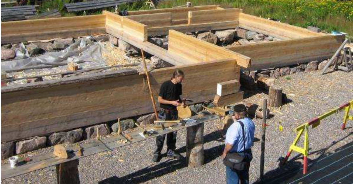
BILD 2. Under 2008 rekonstruerades tre varv på syllarna, samtliga gångöppningar är påbörjade. På bilden ser vi de tre rumsbildningarna från sydväst: långhus, kor och sakristia. Rekonstruktion och kommunikation – två sidor av ett mynt. Niklas Alexandersson förevisar en del av de autentiska träbearbetande handverktyg som används i rekonstruktionen av Södra Råda gamla kyrka, besökaren dokumenterar. Foto Södra Rådaprojektet.
