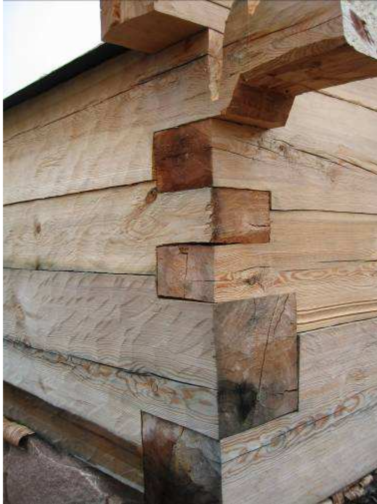
BIILD 5. Långhusets sydvästra hörn. Knutskallar lämnades för att underlätta demonteringen av väggtimret under arbetets gång. Foto Robert Carlsson.
