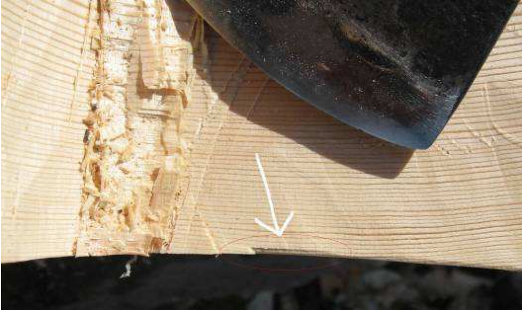
BILD 6. Vi ser upphugget av en hörnknut, i nedre kant har huggningen brutit igenom en rit (se markering), som man sedan håller jämnt öppen allt eftersom huggningen färdigställs.
