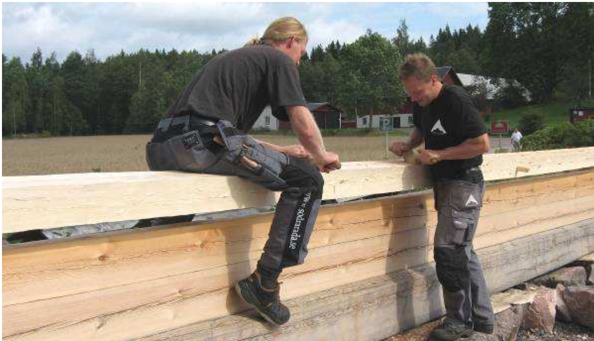
BILD 13. Bengt Bygdén och Daniel Eriksson hyvlar insidan av LN 4. Som synes är den närmare 11 meter långa stocken draghuggen och färdigdymlad. Foto Robert Carlsson.
