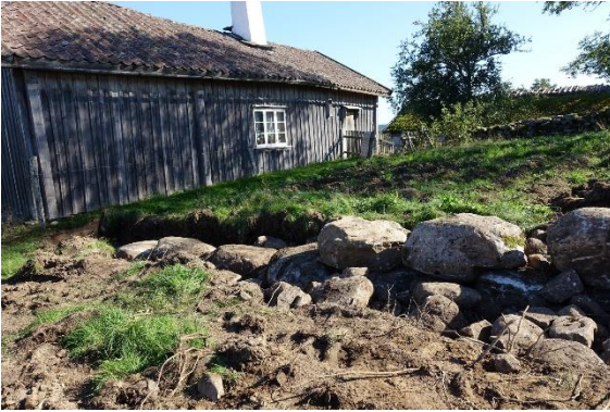
De största stenarna läggs i botten.
